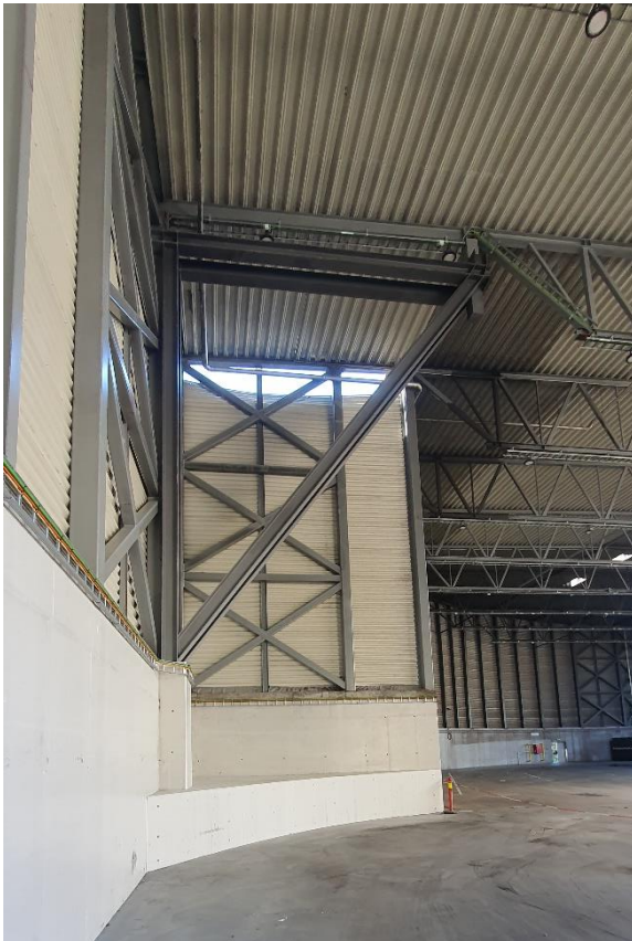
Figur 5-29: Glippe fra bøyde elementer sørvest i tømmehall. Bilder fra 11. august.
