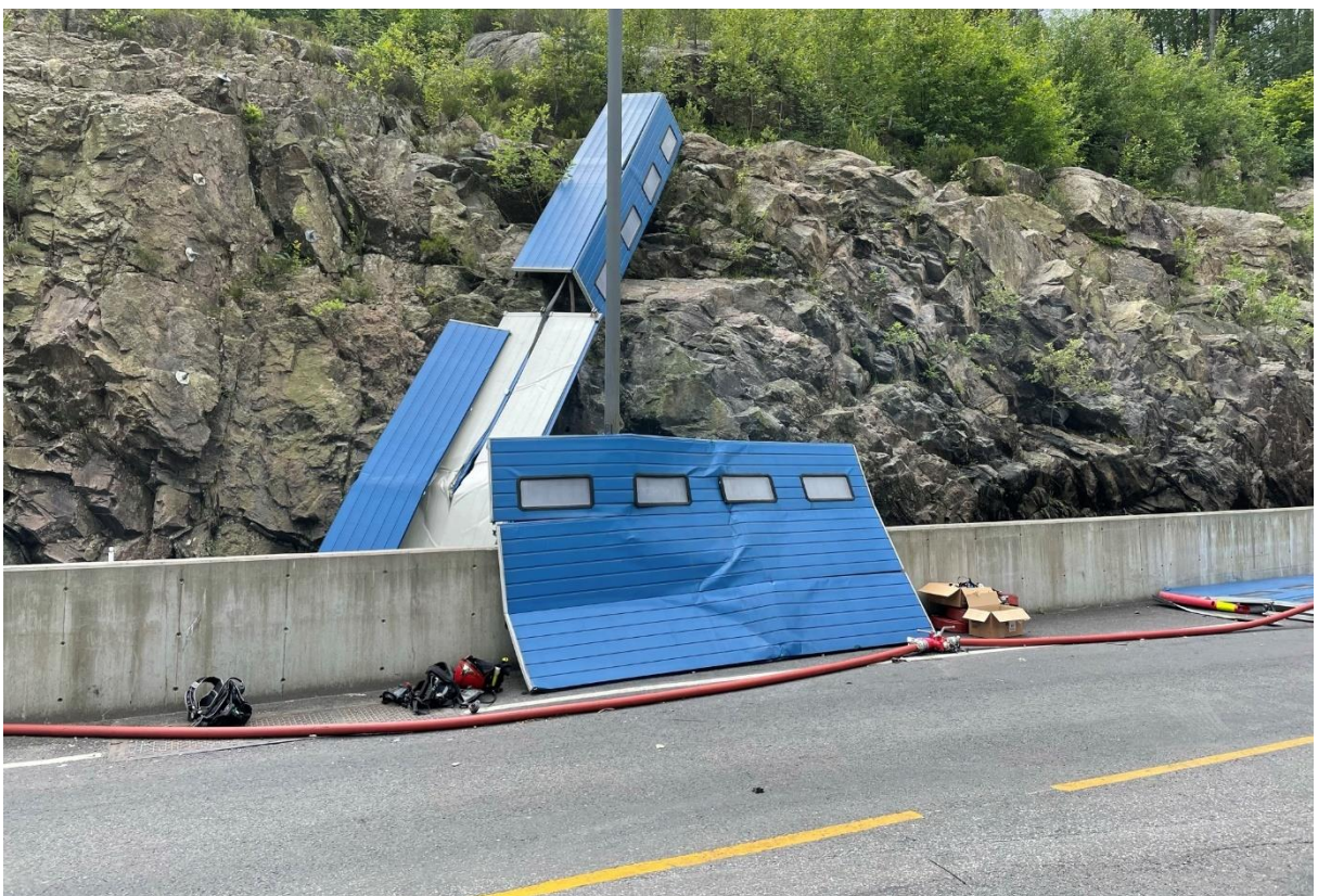
Figur 5-32: Noen porter ble slått ut med nok kraft til å treffe fjellveggen, 25-30 m unna. Bilde fra 25. juni.
