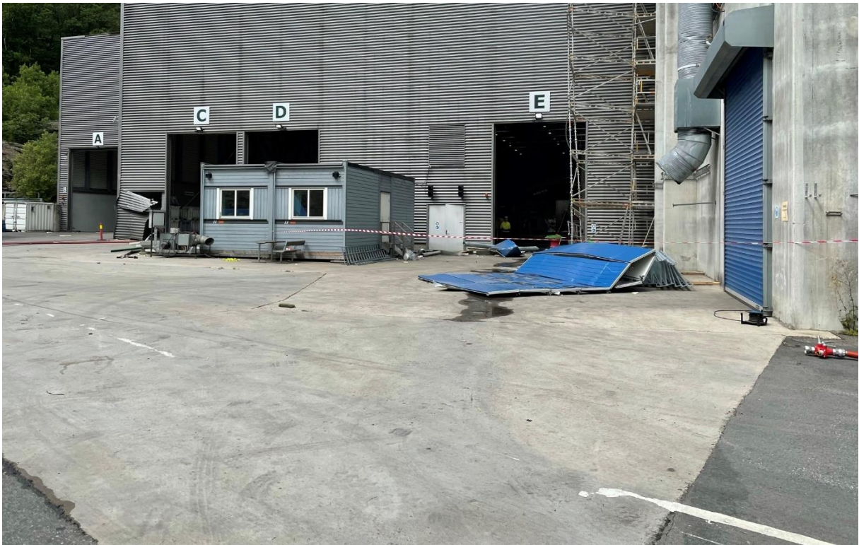
Figur 5-31: Fire porter slått ut. Bilde fra 25. juni.
