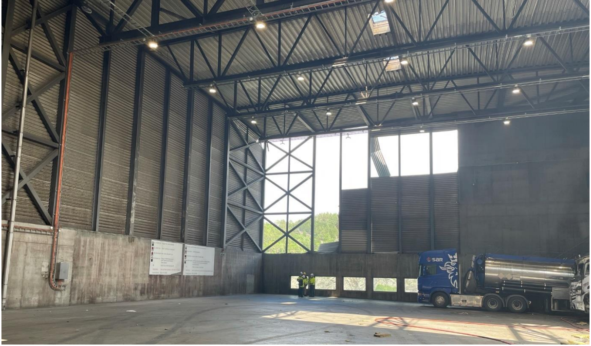
Figur 5-28: Utslåtte elementer i tømmehall. Bilde fra 25. juni.
